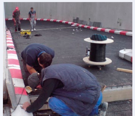
Vjezd do podzemní garáže, Lublaň, Slovinsko
