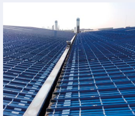
Průmyslová hala, Rumunsko
