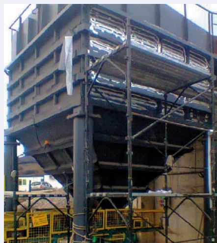
Protimrazová ochrana zásobníku, Bulharsko
