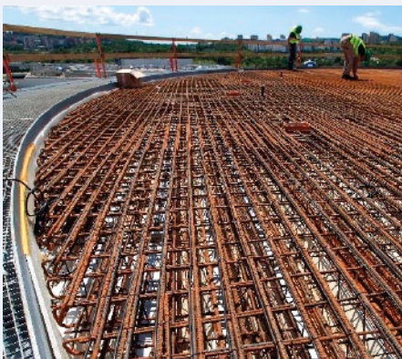
Heliport, nemocnice Bory, Bratislava, Slovensko
